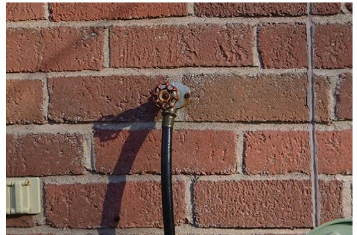
Robinet d'arrêt d'eau extérieur
