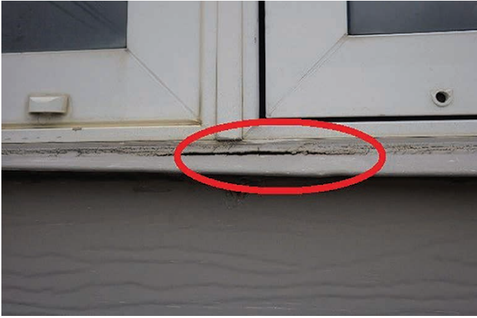
Calfeutrage fissuré/desséché
