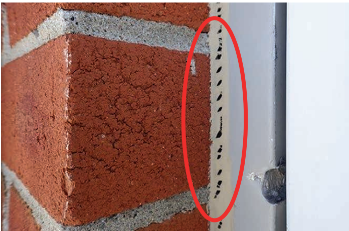
Calfeutrage fissuré/desséché
