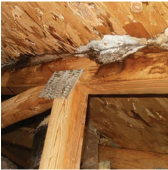
Cernes d'humidité dans un entretoit
