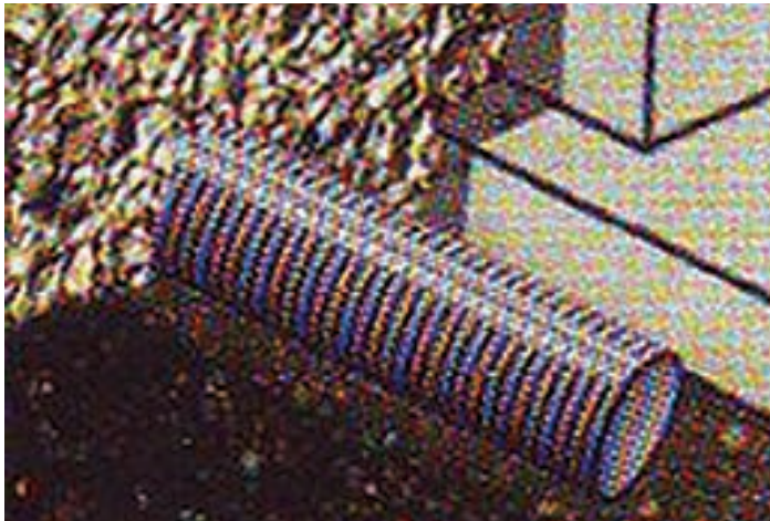
Drain flexible (le plus fréquent)
